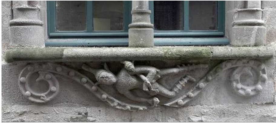
Figure 7. Appui de fenêtre du 20 rue d'Embas à Vitré, cl. Bègne Bernard © Région Bretagne
