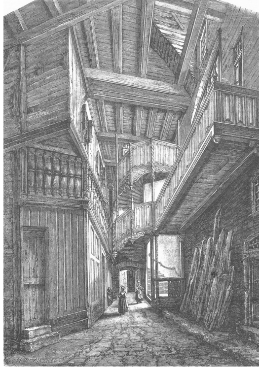
Figure 5. Escalier du seizième siècle, rue Notre-Dame, 7, à Vitré (Ille-et-Vilaine), cour intérieure du 23 rue Notre-Dame à Vitré, gravure de Catenacci.
